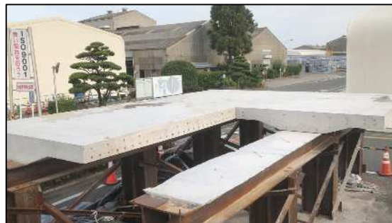
図-3 床版切断状況
