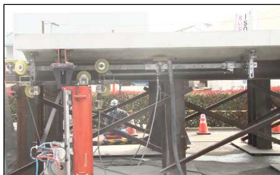
図-1 実物大試験体を用いた切断試験状況
