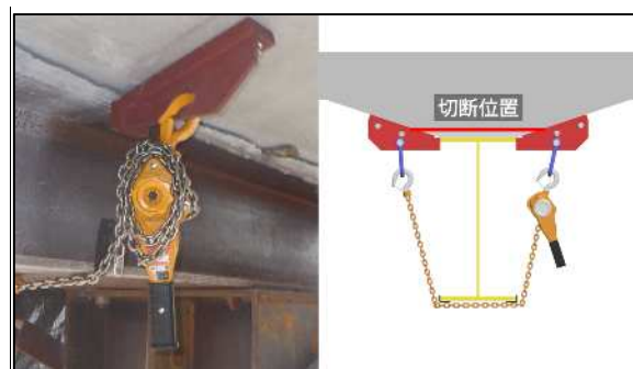
図-7 専用固定治具取付け状況詳細
