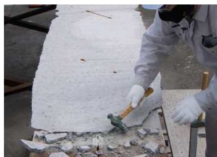
図-5 桁上のコンクリートの撤去状況
