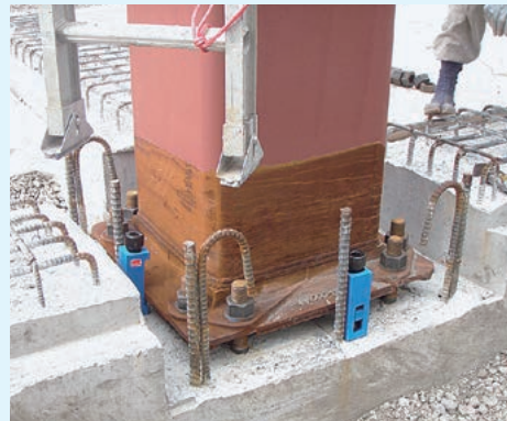
重量: 約4kg 耐力: 20t(30mm仕様)、30t(50mm仕様)【実験値】 ※能力不足時は複数使用
